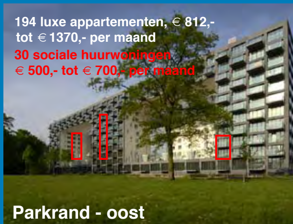
De sociale huurwoningen zijn van buiten niet te herkennen en zijn telkens via één en dezelfde entree bereikbaar als de marktappartementen.
